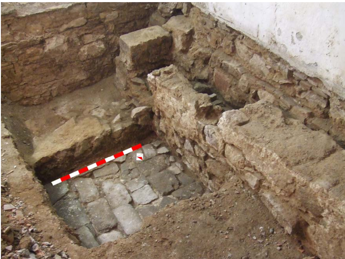
Fotografia núm. 31: Vista general de les restes documentades
