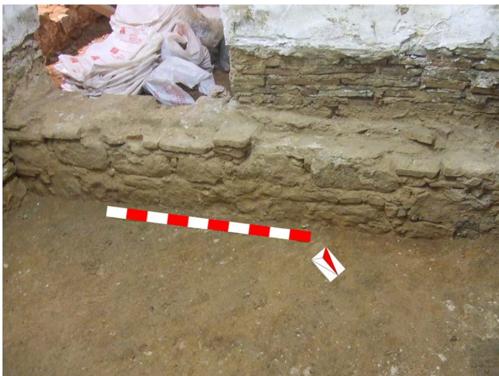
Fotografia núm. 13: paret SW de l'àmbit 2
