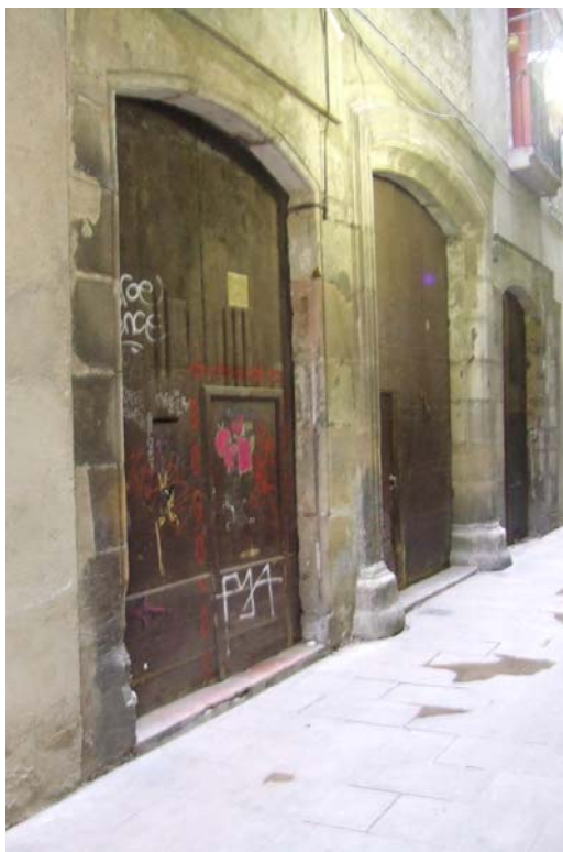
Fotografia núm. 1: exterior de l'edifici
